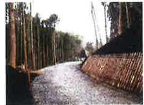
林道の法面緑化 (福島県楢葉町)
